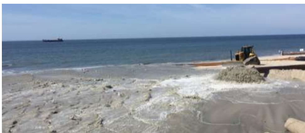
Figur 7-7 Indpumpning af marint sand via rørledning, foto fra kysten på Sild. Indpumpning ved udmundingen ses i forgrunden til højre mens sandsugerfartøjet ses i baggrunden til venstre.
