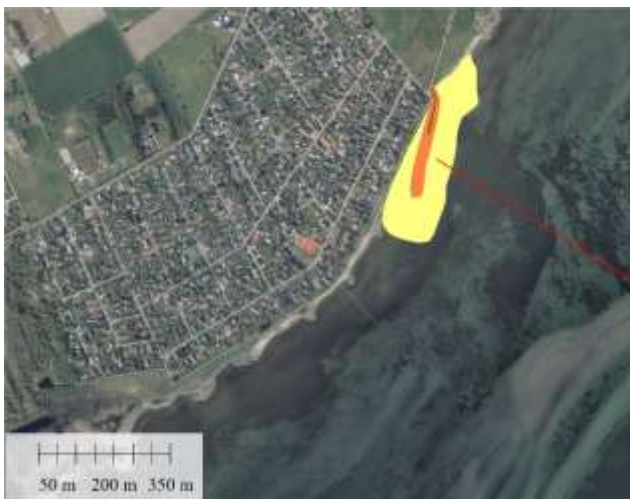
b) Marint sand indpumpes indtil sandfyldet kommer over vandspejlet og "sandbunken" bliver landfast. Der graves nu en rende (orange), som inddæmnes af indpumpet sand-dæmning over vandspejlsniveau (kote +0,5 å +1,5), Lærkerne (brun) etableres løbende i den gravede rende og af-dækkes løbende med sten på lerkernens forside.
